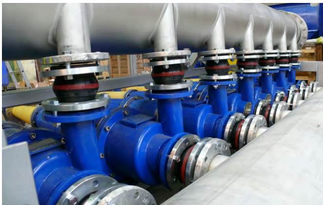
Detail spirálních typů vstupních těles, stanice třídičů SVO-25 určená pro zákazníka z Egypta
