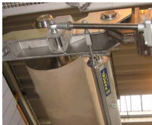
Иллюстрационная фотография из контрольного монтажа сеточной части. Контрольный монтаж шабера грудного вала.
