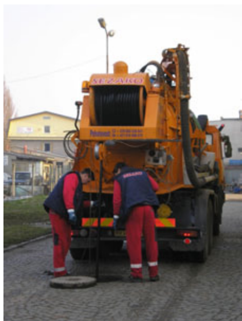
Oprava kanalizace / Repair of sewerage system
