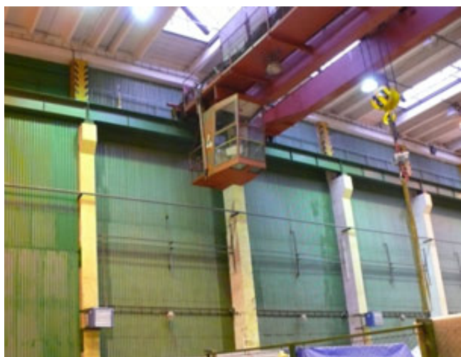
Opravy jeřábů a jeřábové dráhy / Repairs of cranes and crane track
