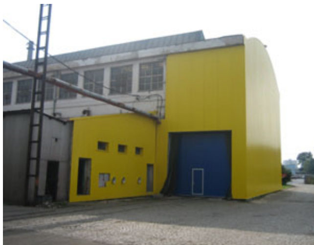
Oprava komunikací v areálu / Repair of roads in areal
