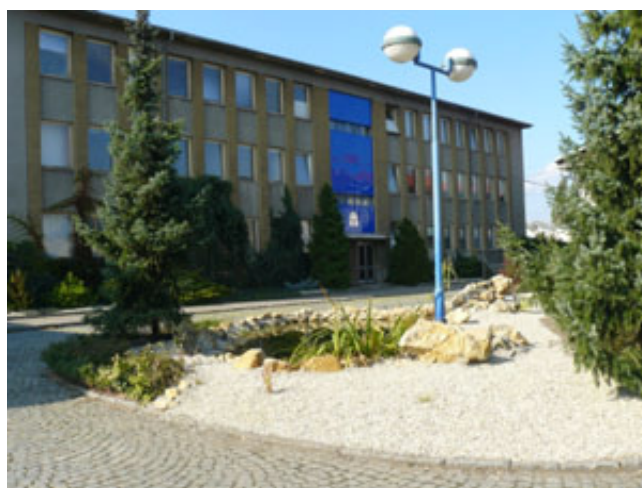
Oprava jezírka / Repair of lake
