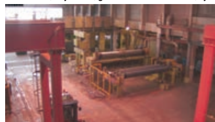
Fotografie z demontáže PS
