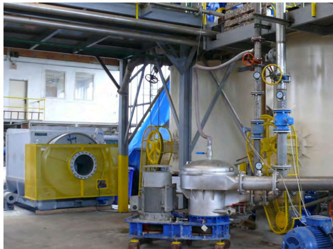
Provozní zkoušky STU na firemní zkušebně
